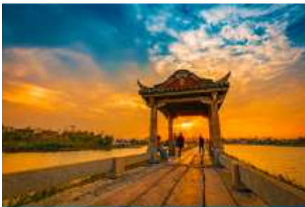
สะพานอันผิง
